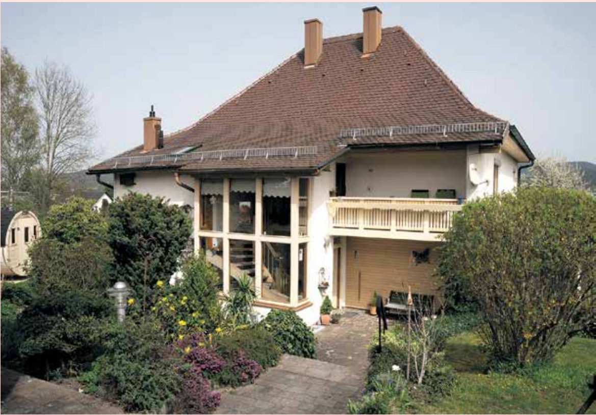
Das rund 100 Jahre alte Zweifamilienhaus in Viechtach wurde im Zuge der Modernisierung bereits auf einen späteren Wärmepumpenbetrieb vorbereitet. Die Kombination aus dem Flächenheizungssystem x-net C16 und den Wärmepumpen-Heizkörpern x-flair verbindet hohen Wohnkomfort mit den Anforderungen moderner Niedertemperatur-Systeme.
