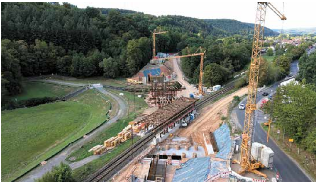
So sehen die Bauarbeiten aktuell aus.
