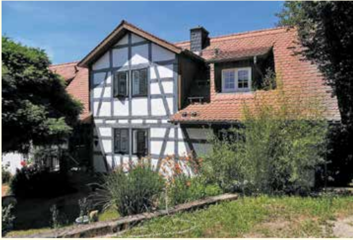
Denkmalgeschütztes Fachwerkhaus (Einhaus) in der Kirchbrombacher Straße 19. Foto von Brühl auf Wikipedia
