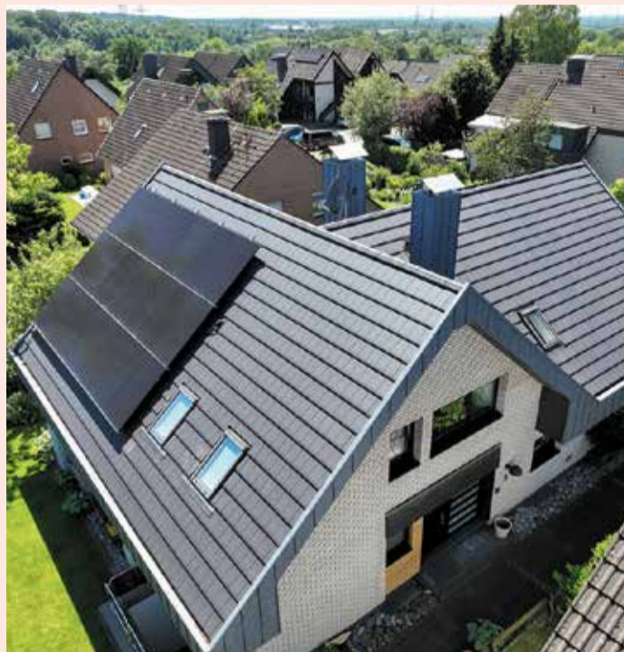
Ein saniertes Dach bietet zuverlässigen Schutz vor Extremwetterereignissen, dämmt gut und steigert den Wert der Immobilie.
